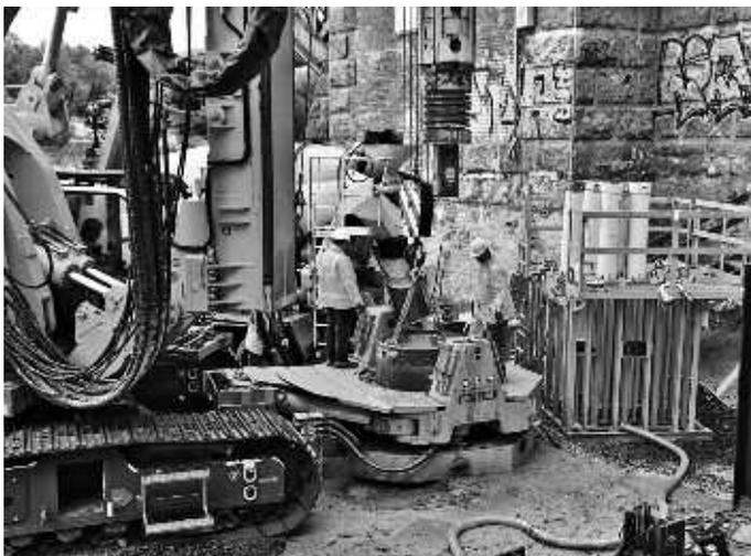
Betonage eines 30 Meter tiefen Bohrpfahls für das Fundament der neuen Ersten Levensauer Hochbrücke (Bild: WNA NOK)
